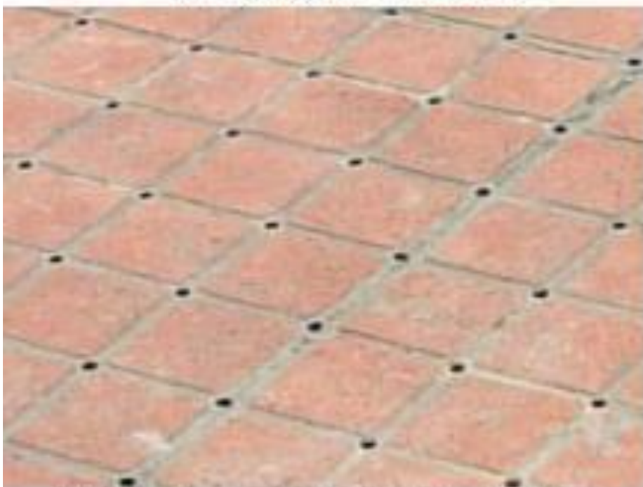
環保透水透氣混凝土鋪面
