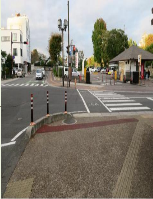
防撞桿+緣石防護案例(日本)
