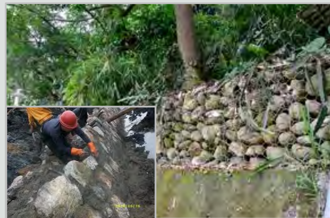
山區道路砌石擋牆
