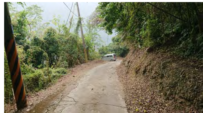
道路鋪面現況
