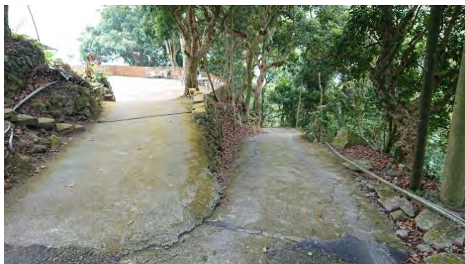
道路臨側居民住處通道
