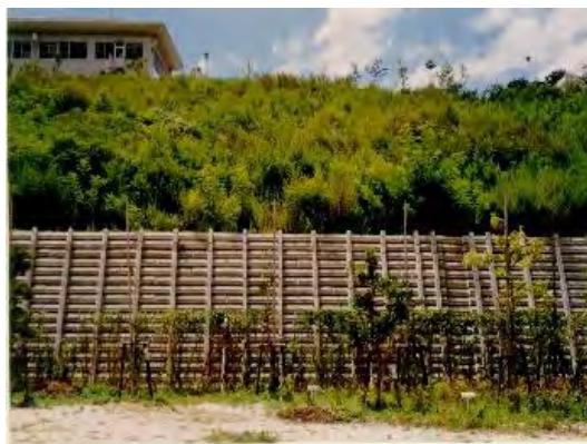
格床式(框條式)擋土牆
