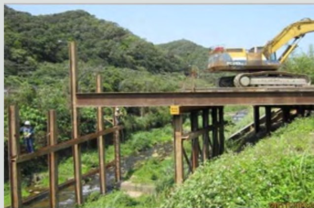
局部路段設置鋼棧橋通行
