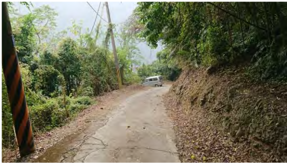
道路鋪面現況
