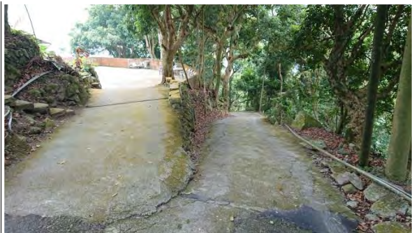
道路臨側居民住處通道
