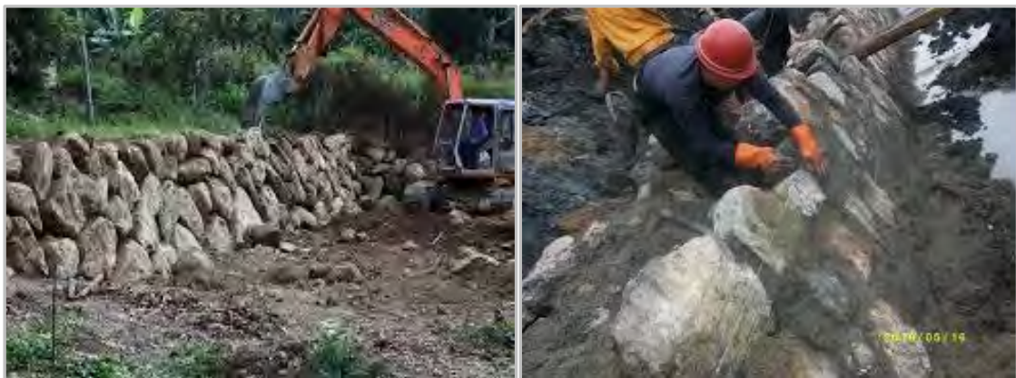
圖 7.7-8 砌石施工示意圖
