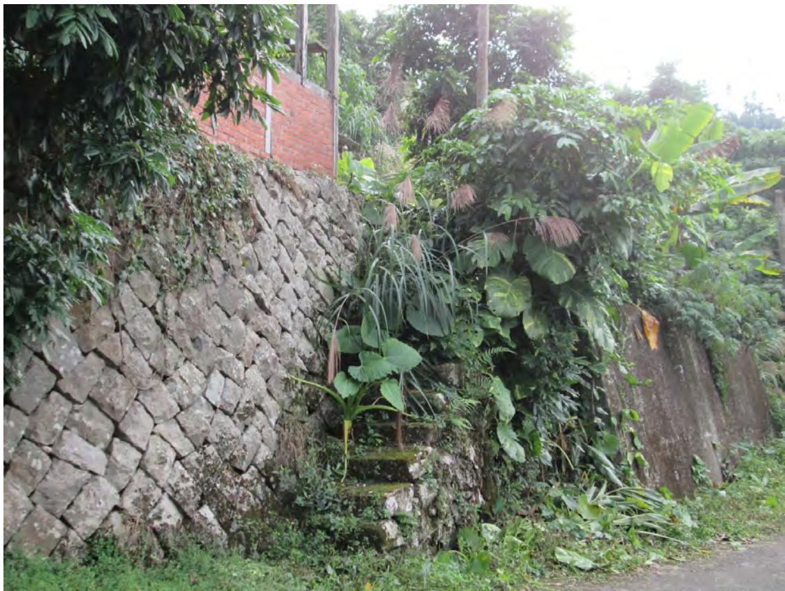
圖 7.7-7 山區道路砌石擋牆現況照片
