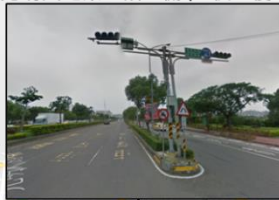
光明六路東一段左側(三快二慢車道)
