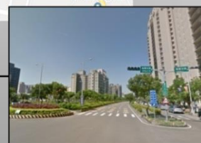
光明六路東二段快慢分隔(慢車道一車道)
