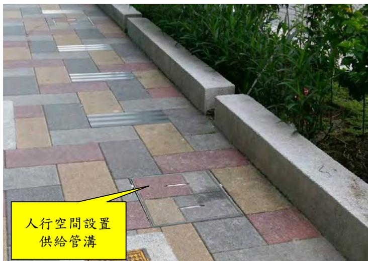
圖 26 設置供給管溝示意圖
