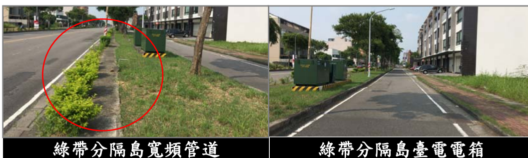
圖 21 綠帶分隔島管線設施現況照片
