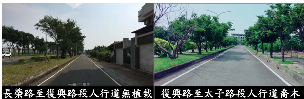
圖 19 人行道植栽現況照片
