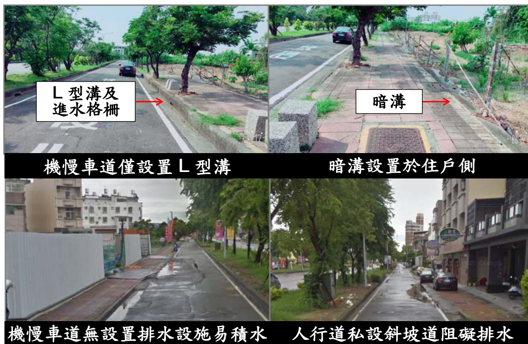
圖 41 機慢車道及人行道排水設施現況照片
