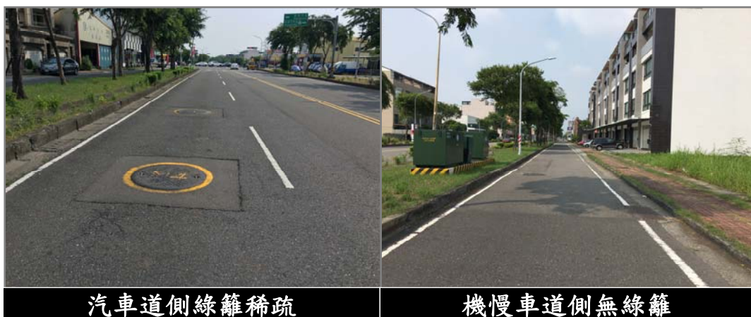
圖 32 分隔島植栽現況照片
