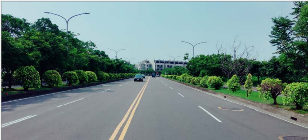
圖 18 長榮路至復興路段之汽車道植栽現況照片
