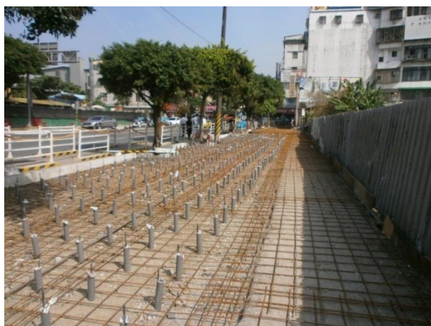
圖 4.3 管式透水性鋪面工法
