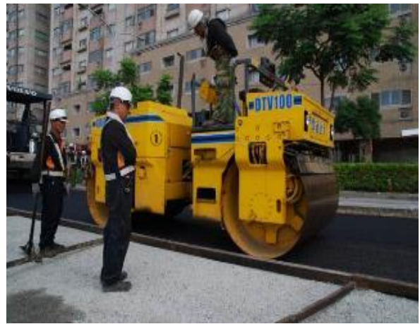
圖 5.7 多孔隙瀝青混凝土滾壓
