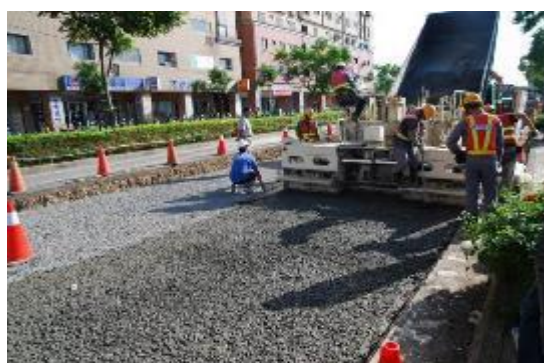
圖 5.3 透水混凝土鋪設
