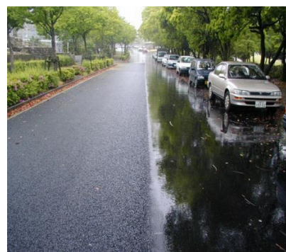
圖 1.2 透水性與不透水性鋪面比較
