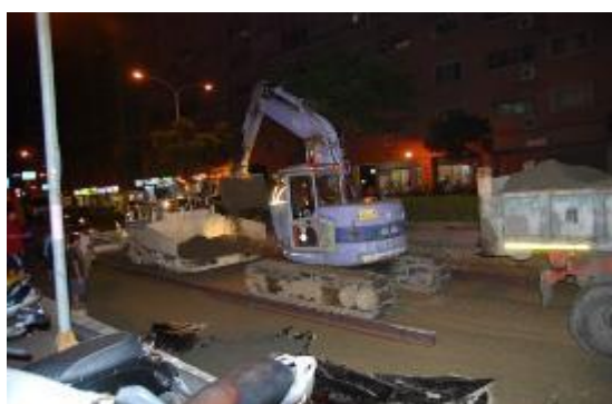
圖 5.2 透水混凝土鋪設
