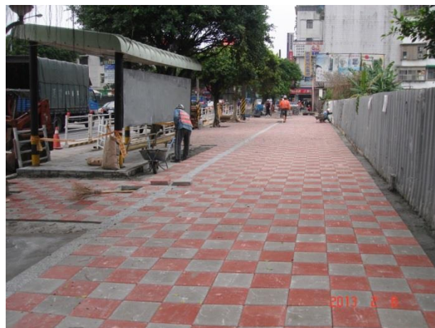
圖 4.4 管式透水性鋪面工法完成圖
