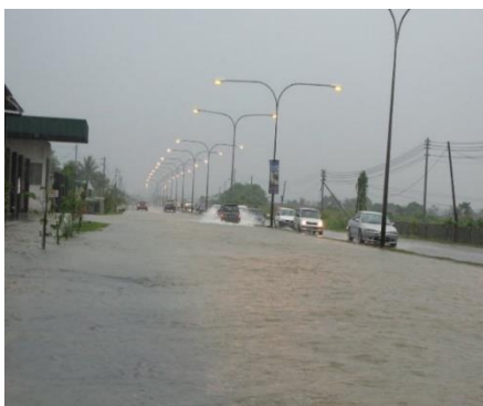
圖 1.1 豪大雨肆虐市區道路造成水患
