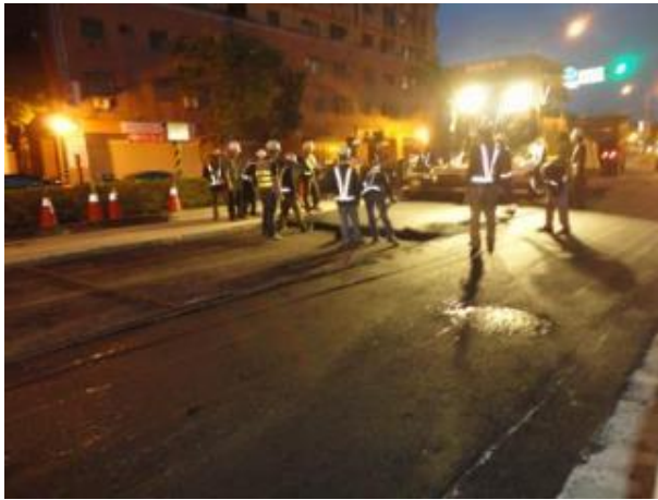
圖 5.6 多孔隙瀝青混凝土鋪設
