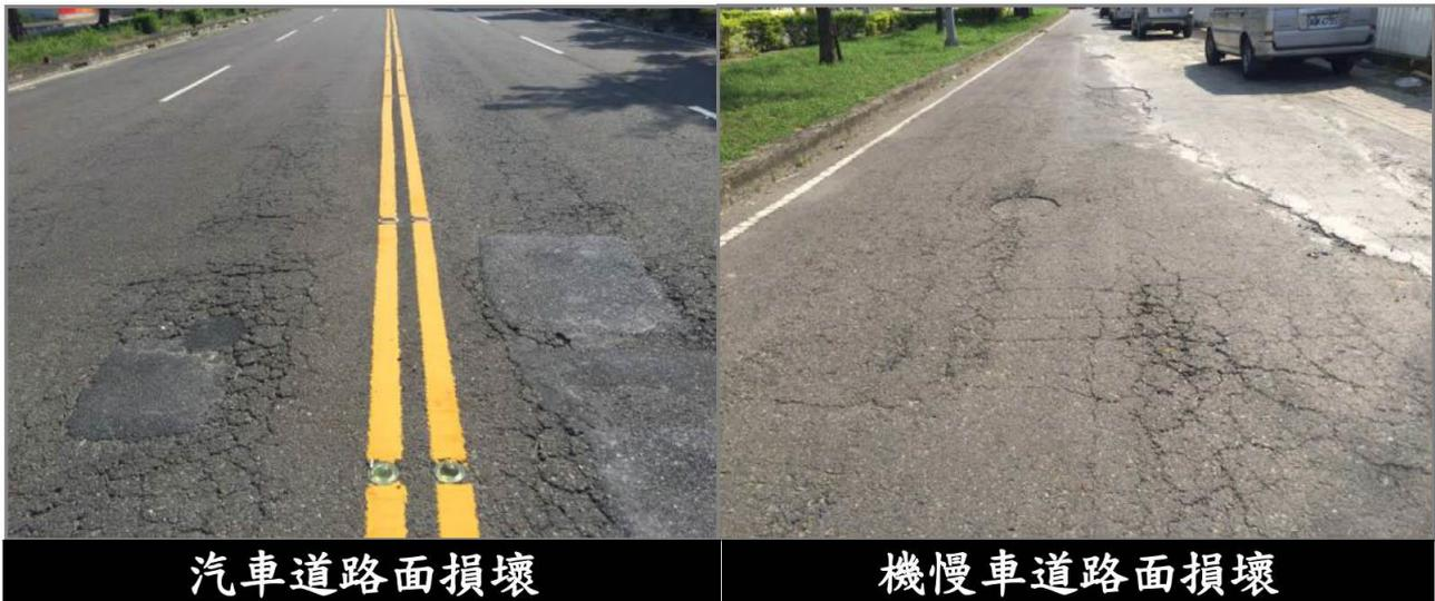
圖 32 車道路面損壞現況照片
