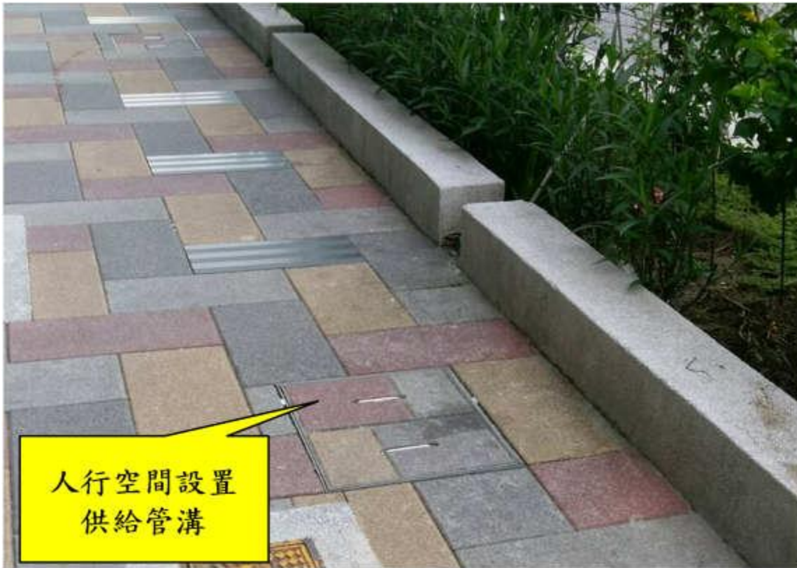
圖 13 設置供給管溝示意圖
