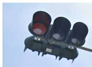
圖 3.1-16 帽式罩簷及筒式罩簷之樣態
