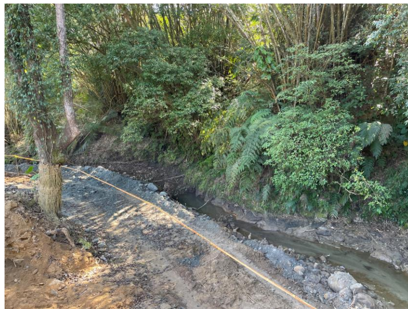
工區及樹木區邊緣設置圍籬或警示 帶，避免進入及亂丟垃圾
