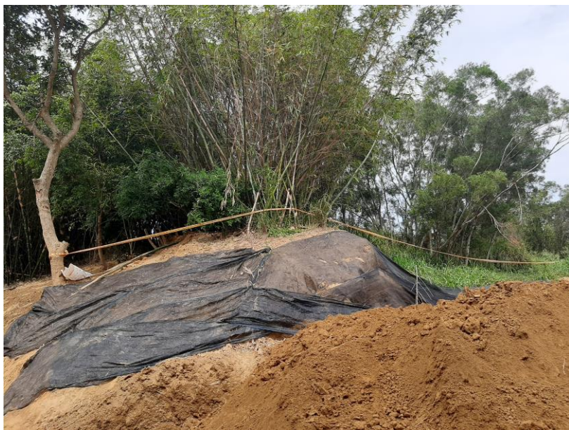
裸露地 、 儲料區 、 堆土區 、 砂石車車斗 等以防塵網覆蓋
