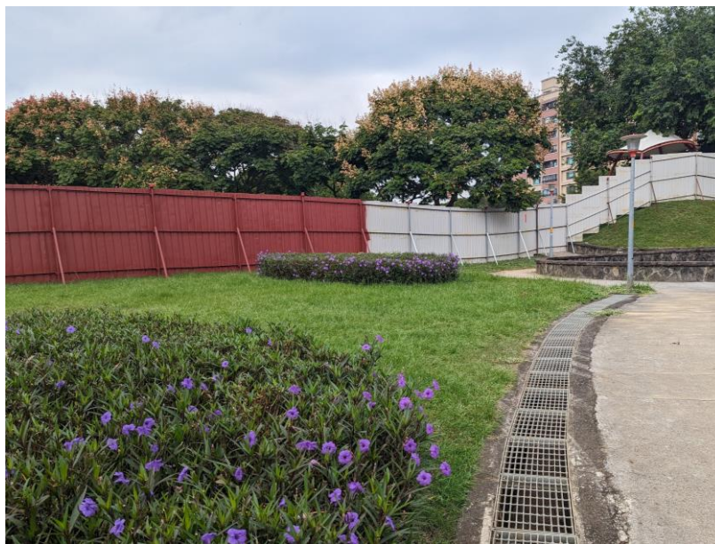
設置與地面密合之施工圍籬或栽植緩衝綠帶
