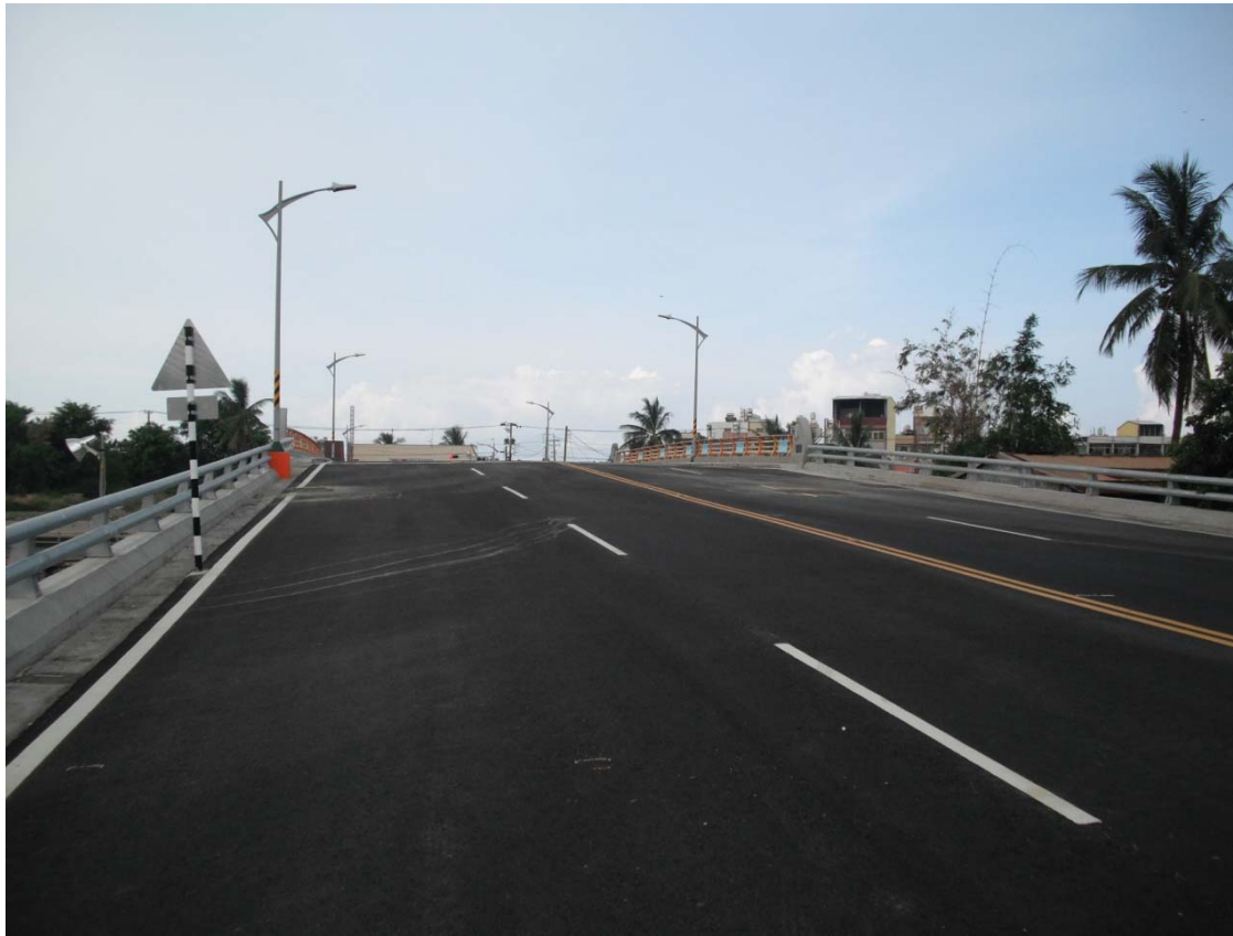
圖 3.2-10 屏東縣東港鎮 2-4 號計畫道路新闢工程
