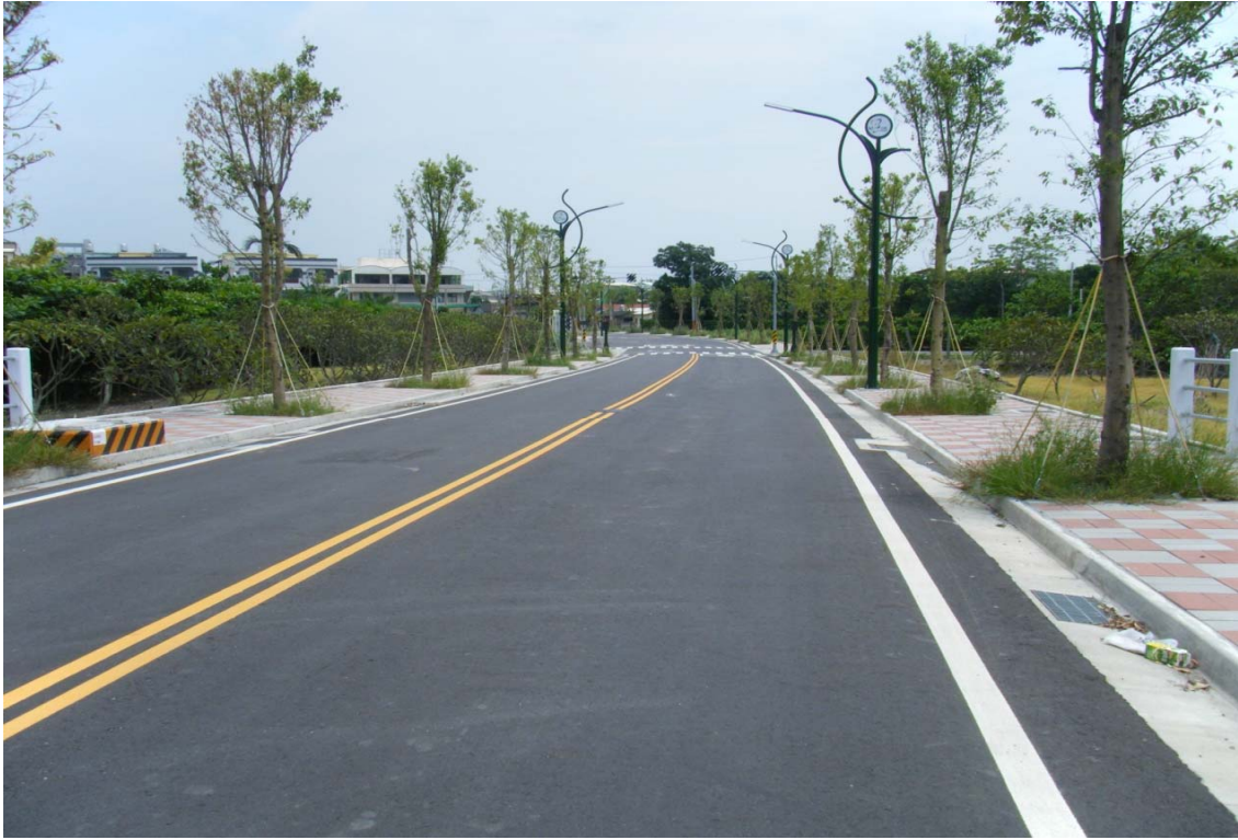
圖 3.2-9 田尾園藝特定區 III-4 號道路工程
