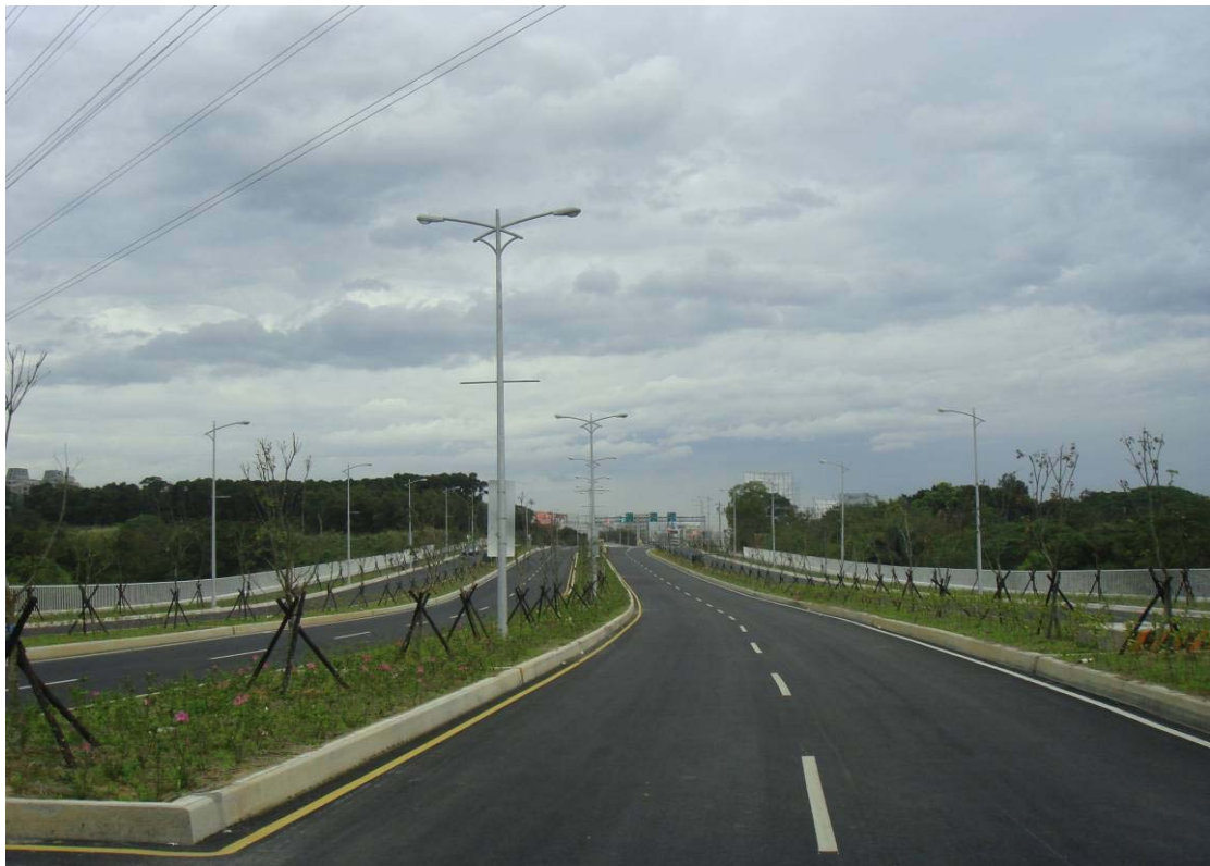
圖3.2-8新竹市公道路五向東延伸工程
