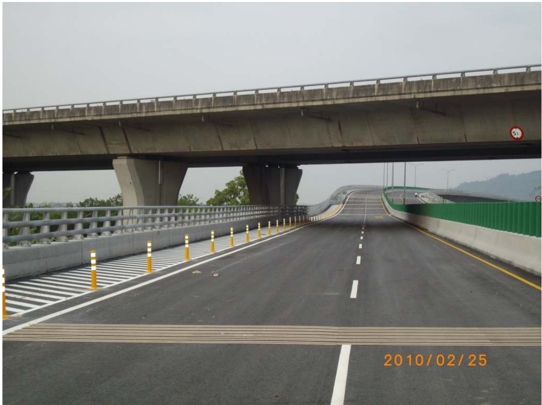
圖 3.2-5 祖祠橋新建工程
