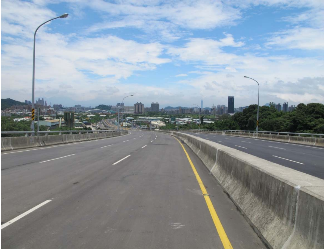
圖 3.2-1 新北市安坑一號道路
