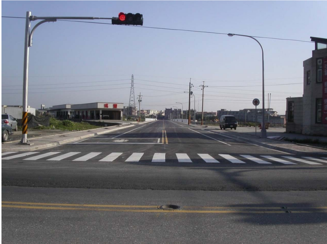
圖 3.2-3 蘇澳鎮新馬地區 19 號道路新闢工程
