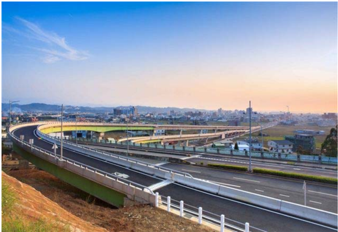
圖 3.2-6 竹南科學園區南側聯外道路興建工程(第一期)
